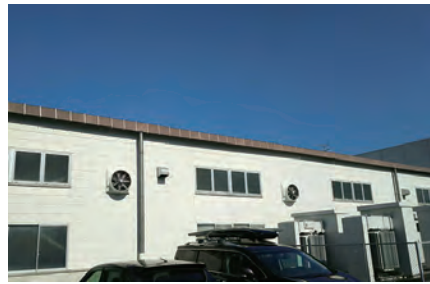
住友電工産業電線株式会社宇都宮工場 17台 (栃木県宇都宮市)
